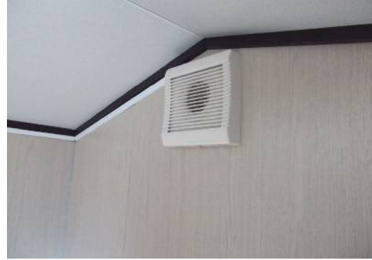
室内換気ファン 照明と同時に作動 照明消灯後5分後に停止
