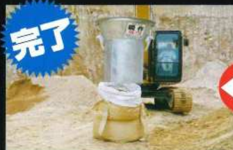
④「瞬作」を抜いて作業完了
