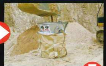
②バケツで「瞬作」に土砂を入れる
