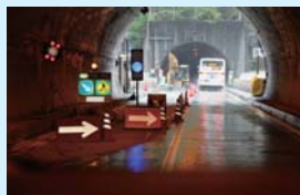
トンネル工事に
