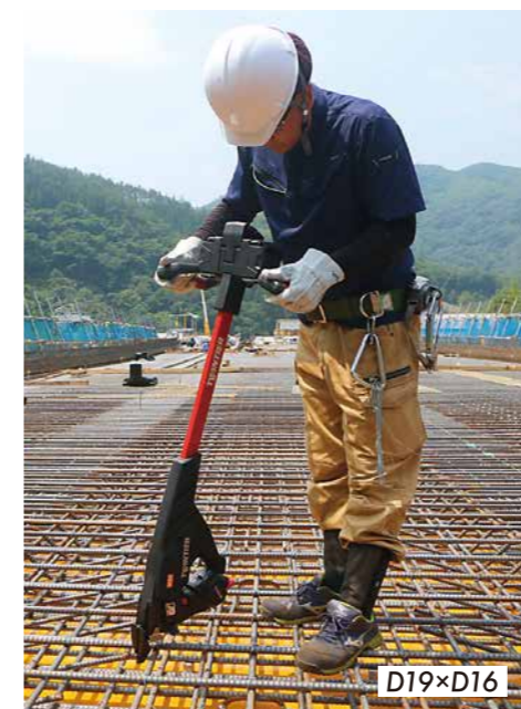
橋梁RC床版
