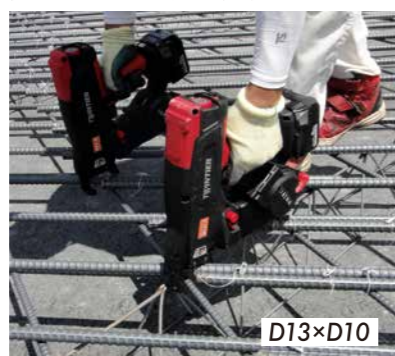
高速道路床版の鉄筋結束作業も2台同時使用でスピーディーに。
