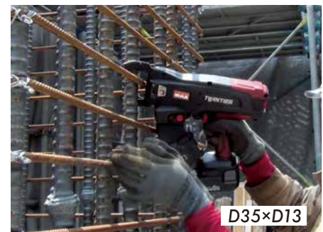
建築の梁・柱にも使用。
